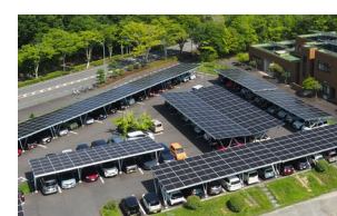
創エネルギー設備の整備
