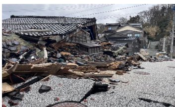
【旧角海家住宅(重要文化財)】
