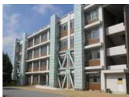
老朽改善された施設
