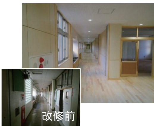
廊下の壁を一部撤去して多目的スペースを整備
