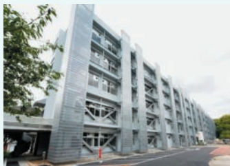
耐震補強と外壁の改修
