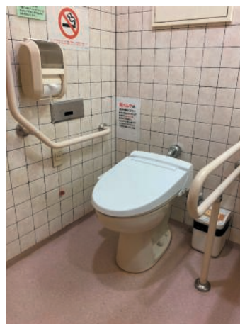
車いす対応トイレ
