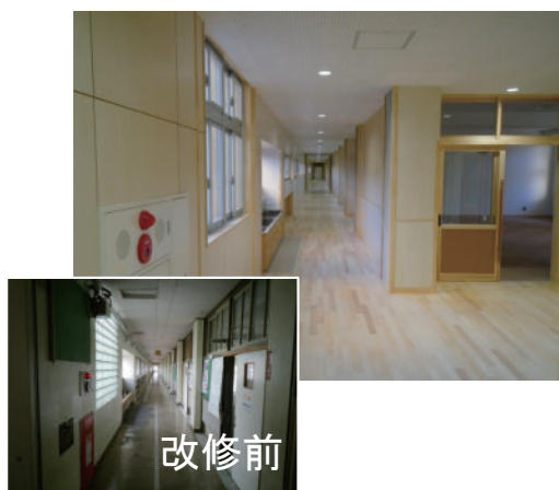
廊下の壁を一部撤去して多目的スペースを整備
