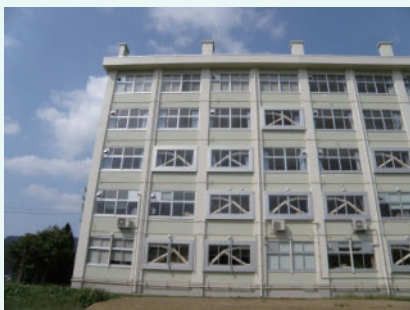
学校施設の耐震化対策 (新潟県立安塚高等学校) 「公立学校施設整備に関する 防災対策事業活用事例集」より
