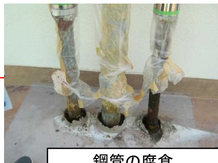
鋼管の腐食
