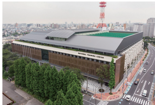
NTC屋内トレーニングセンター・イースト 施設外観
