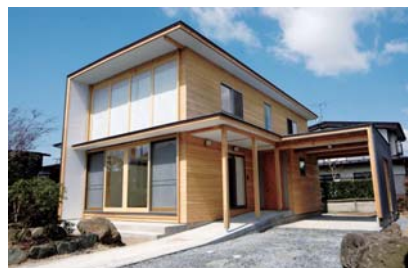
木ダボ接着接合を用いたラーメン構法で建設した住宅
