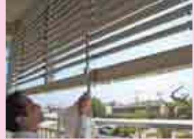
手動式ルーバーにより、季節に応じた適切な光環境をつくることができる。
