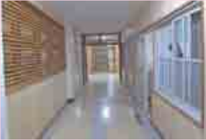
改修前の建具(右側)を残している。
