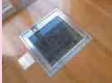
床下に設置された雨水貯留槽の内部を見ることができるようガラス窓を設置している。
