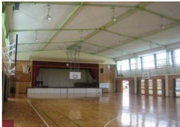
天井撤去後、ノンフロン湿式不燃断材を吹付（現場発泡ウレタン下地）
