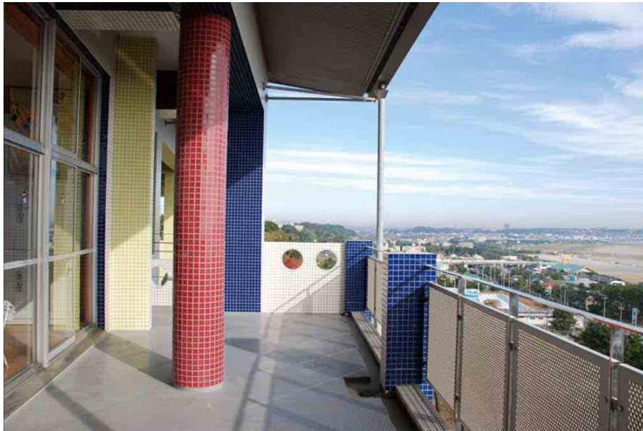
写真 26-1 外壁保護のため小口タイルを使用した海沿いの学校 (茨城県大洗町立南中学校)
