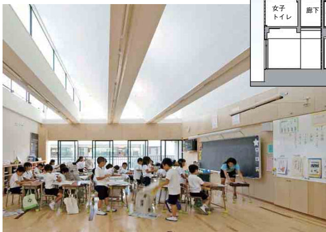
写真 21-1 高窓から天空光を導いた明るい普通教室 (三重県鈴鹿市立旭が丘小学校)
