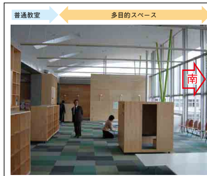
写真 21-4 南に開けた多目的スペースに面する北向きの教室 (広島県呉市立立尻小学校)
