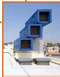
写真 22-2 屋上にある風の塔
