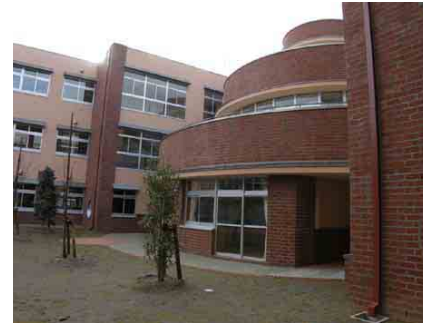
写真 26-2 外断熱を行ったレンガ積みの学校 (新潟県見附市今町立小学校)
