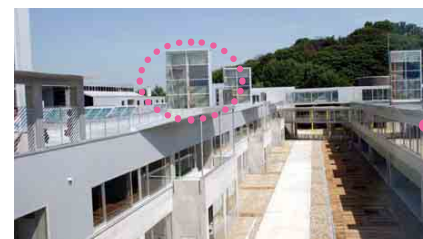
写真 22-5 換気・集熱塔
